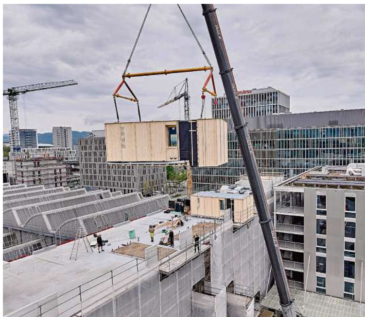
Hoch hinaus; die Tiny-Houses werden per Kran angeliefert.
