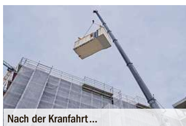
Hoch hinaus; die Tiny-Houses werden per Kran angeliefert.
